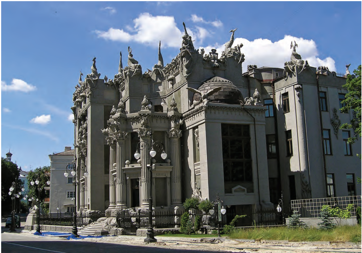
212. «Будинок з химерами» у стилі ар-нуво архітектора Лешека Дезидерія Городецького. Київ, 1901–1903. Фото 2005 р.
