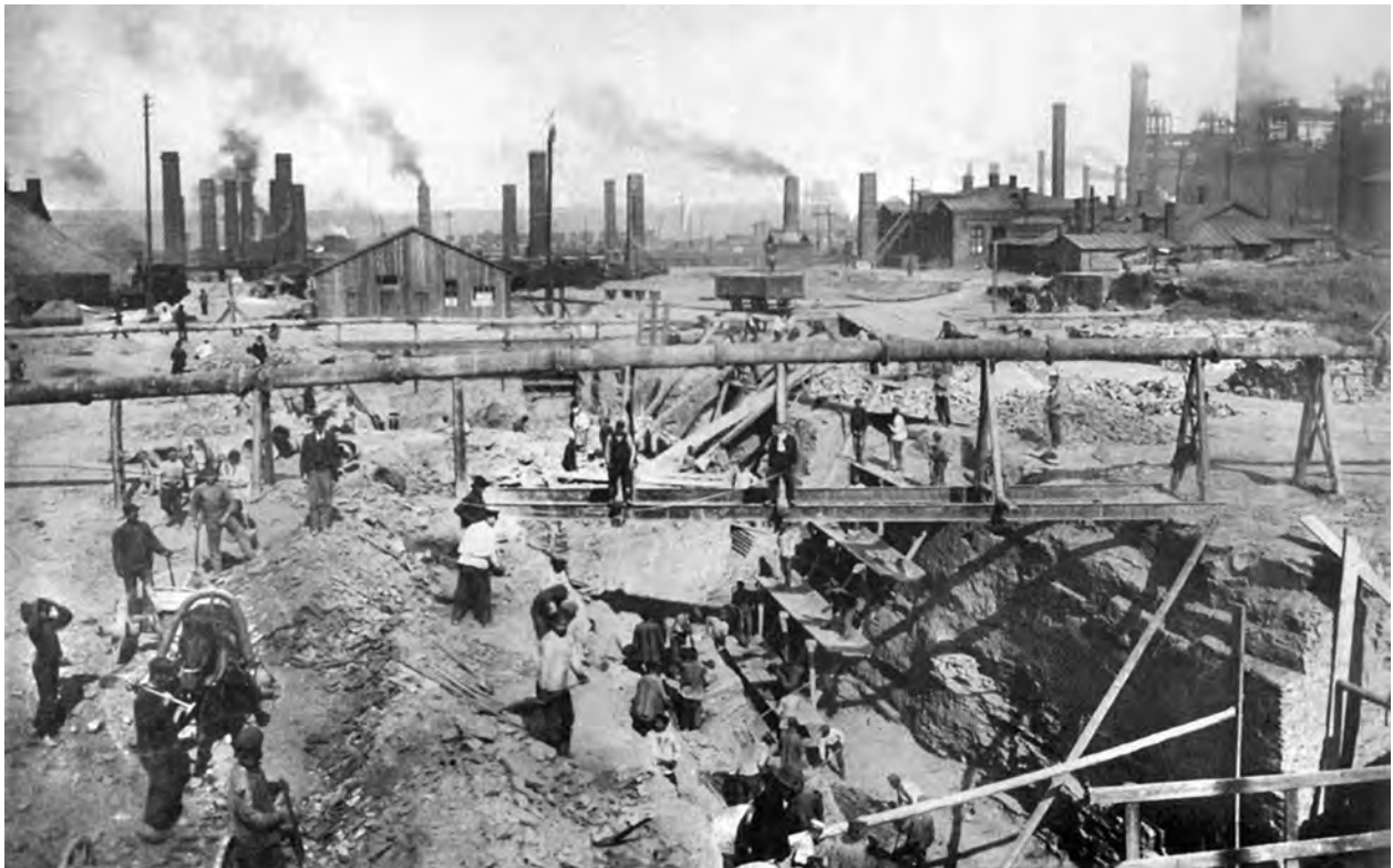
27. Будівництво металургійного заводу (1911) у Юзівці (сучасний Донецьк) – головному промислового центру Донбасу.
