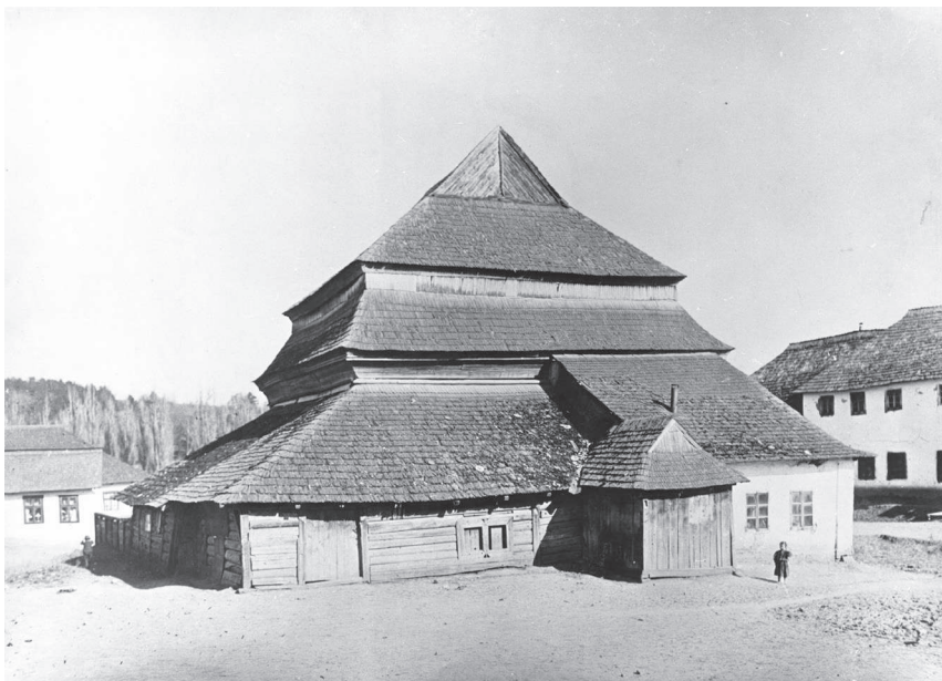
Ил. 2. Гвіздецька синагога, вхід із західного фасаду. Фото бл. 1900 року
