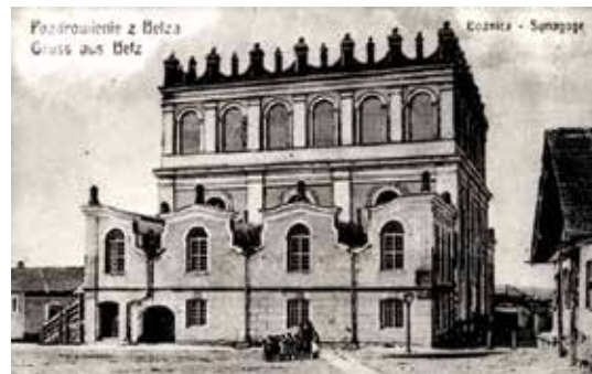
Первісна синагога белзьких хасидів, освячена в 1843 році. Будівлю зруйновано під час Другої світової війни.
