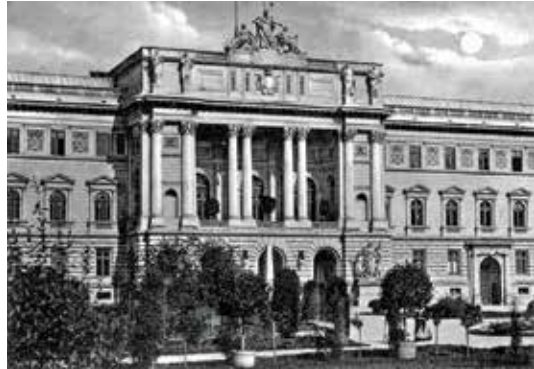
Галицький сейм, який почав діяти 1861 року, отримав власну будівлю (збудовану в 1877–1881 рр.). Сьогодні це головний корпус Львівського національного університету імені Івана Франка. (Фотоархів Центру міської історії Центрально-Східної Європи, Львів)
